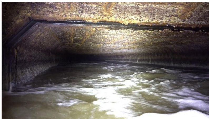
点検調査が困難箇所のイメージ
