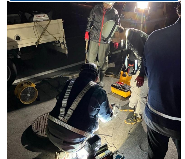
現場点検時の様子
