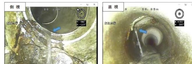
雨天時浸入水量が比較的多く、流れている状況が明確に確認できる状態のもの
