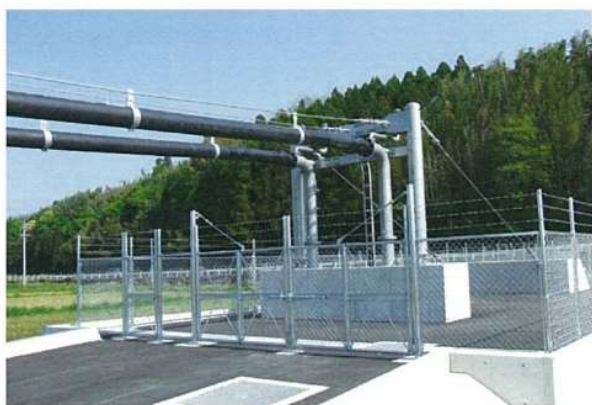
仮設配管布設
