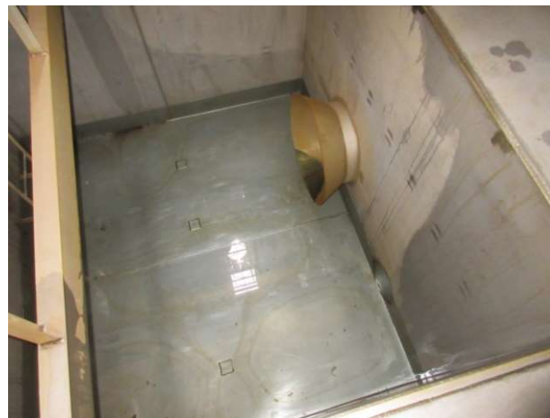
【底部ピット状況】
