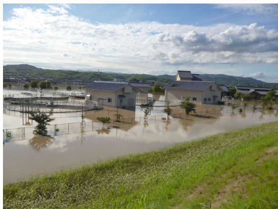
写真-1 本浄化センターの被災状況(H30.7.8)
