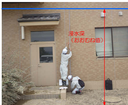
写真・3 緊急調査時の浸水深の確認
