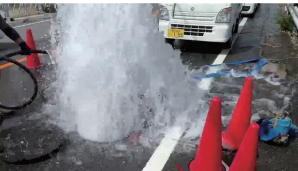
写真－1 漏水による路面への影響 (2025.9)
