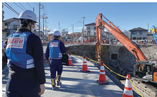
写真－1 八潮市道路陥没現場での現地支援
