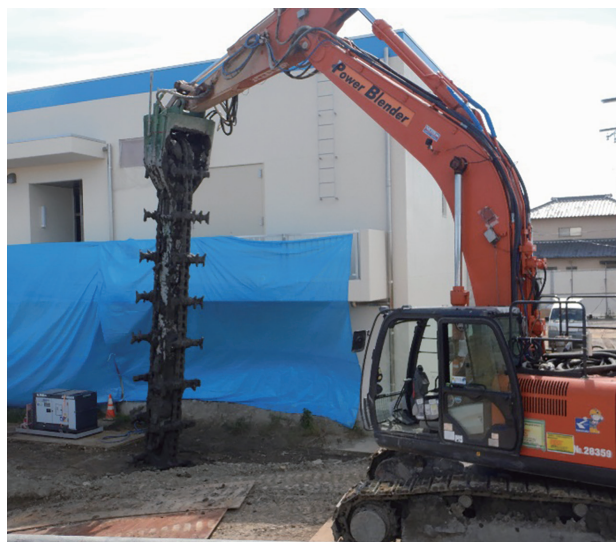
写真－３ 地盤改良工事
