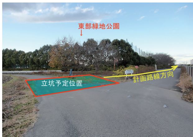
写真－1 立坑現場
