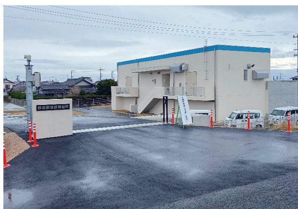
写真－４ 完成建屋
