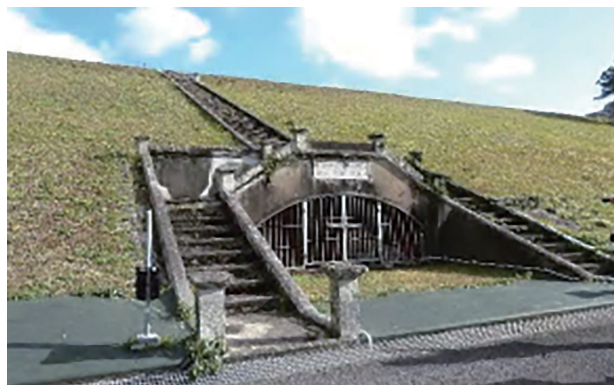
写真-2 日本最初の水道専用ダムの本河内高部堰堤
