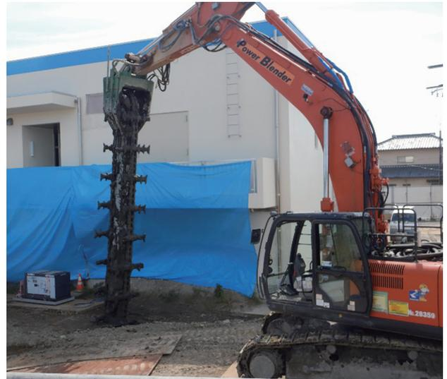
写真－３ 地盤改良工事
