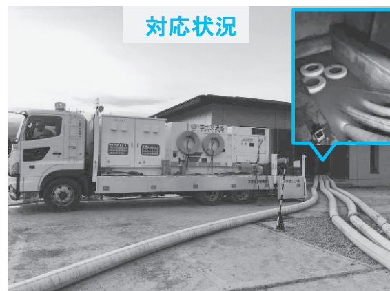
写真－2 国交省の排水ポンプ車により施設内を排水 (長野県千曲川流域下流処理区終末処理場)
