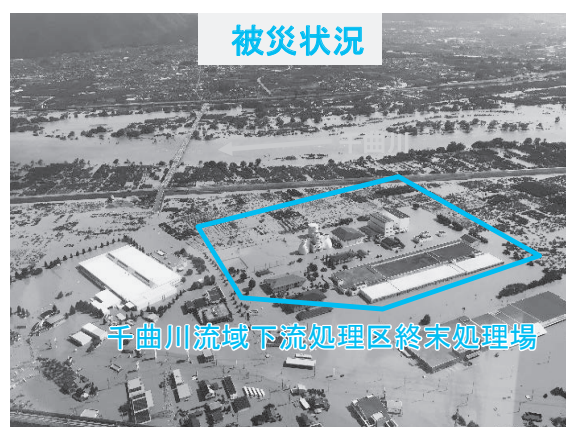
写真－1 浸水した下水処理場 (長野県千曲川流域下流処理区終末処理場)
