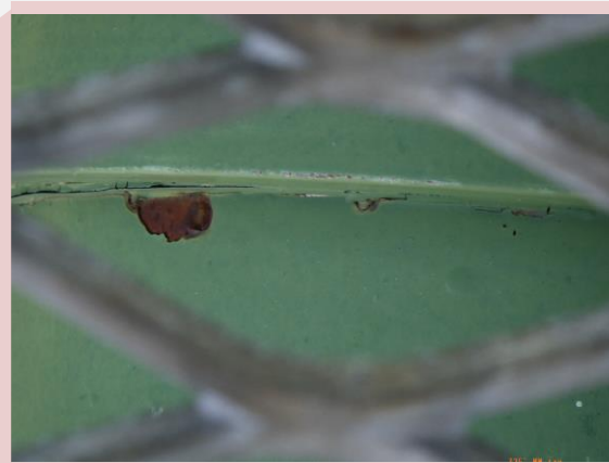
「デジタルカメラ撮影」 歩廊の網目から管が撮影可能
