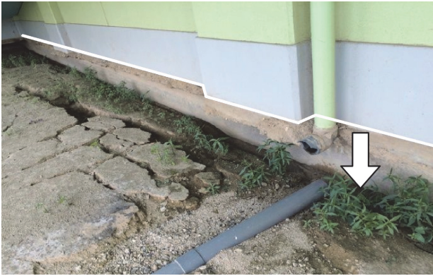
写真8 構造物周辺の沈下状況
