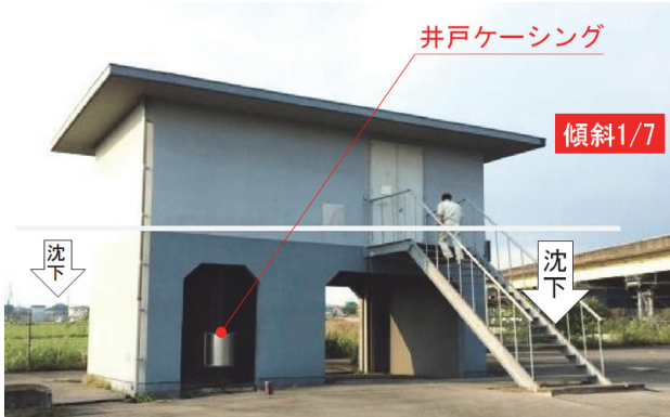
写真5 井戸ポンプ室建屋Bの傾斜・沈下
