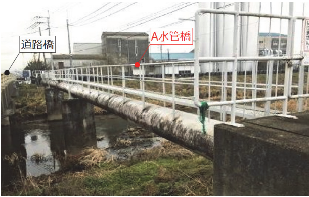
写真-1 水管橋全景
