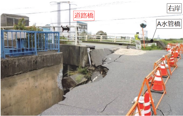
写真-2 道路橋周辺地盤の変状
