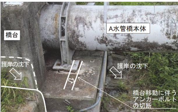
写真-3 護岸沈下・橋台移動に伴う水管橋被害
